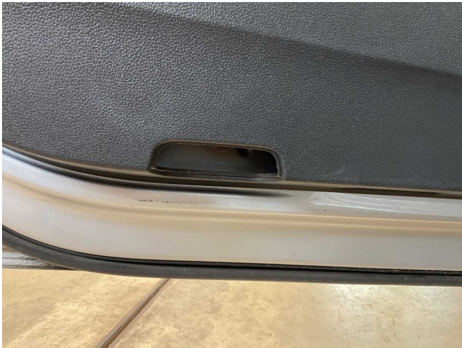
Bild 29 Innenraum Türverkleidung vorne links Blende fehlt
