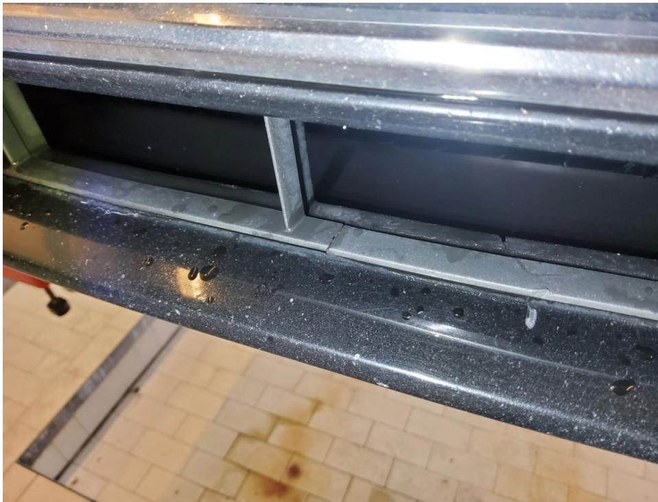
Lüftungsgitter Stoßfänger vorne gebrochen, ern.
